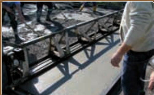
Betonburkolat építése kézi módszerrel
