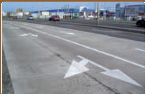
A kísérleti szakasz helyszíne a felújítást követően
