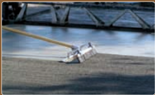
Burkolat- felület éridesítése
